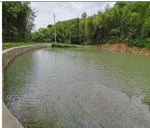
图 2-水体清淤及边坡护砌
